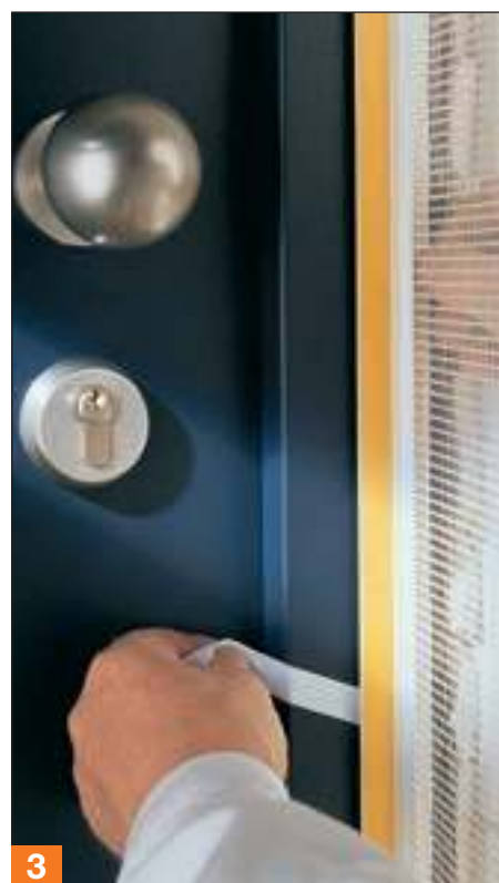
3. Места примыкания к оконным и дверным коробкам
